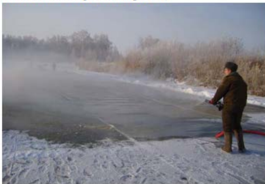
Рис. 3. Поливка участков водой для намораживания льда
