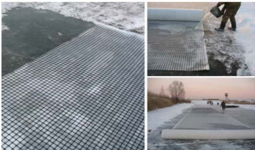
Рис. 2. Укладка и фиксация геокompозита
